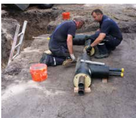
Die Stahlrohre mit Kunststoffummantelung haben eine hohe Wärmedämmung.
